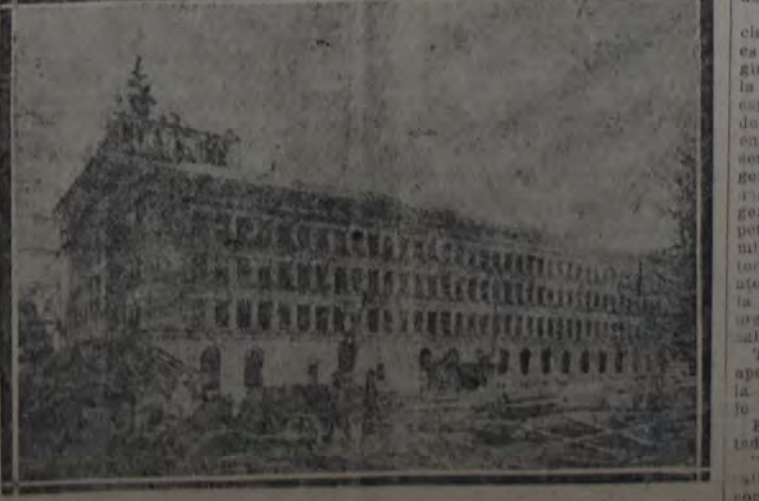
El nuevo edificio de la Oficina Internacional del Trabajo, en Ginebra, en construcción.
